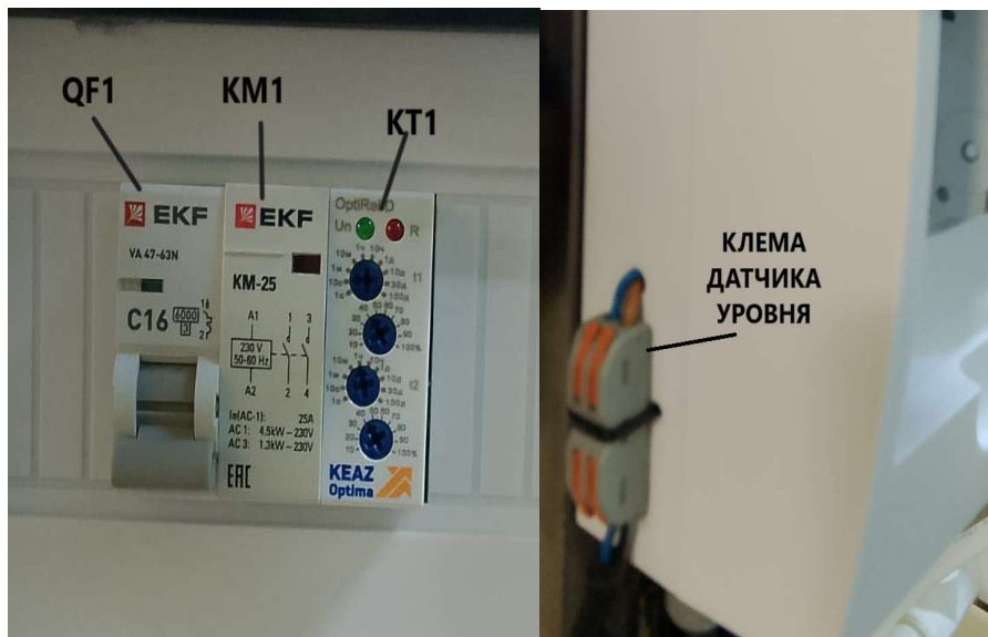
Рис.2 Элементы блока управления.
